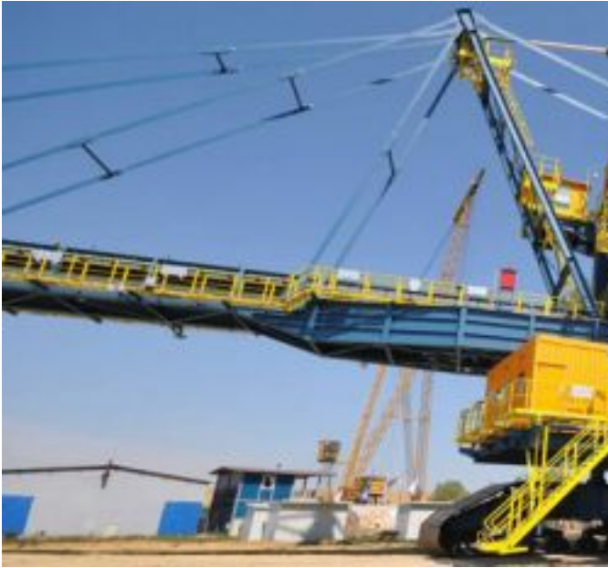
Izrada i montaža odlagača ARS 2000 i kliznog voza, TKF, TE Kostolac, 2007-8 Zoom
