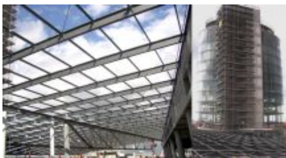
DaimlerChrysler AG, Nova Filajala München, isporuka i montaža 1200 t, zavarene konstrukcije
